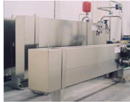
在Ålmhult使用的洛克比产品，泥/水热交换器和泥/泥热交换器组。
