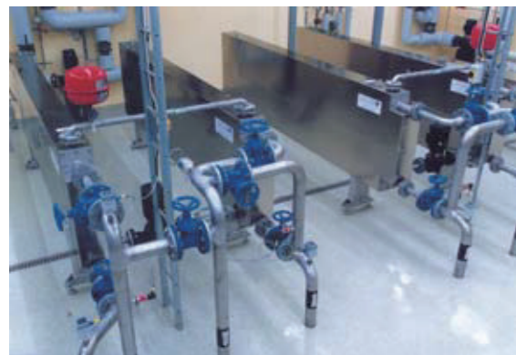
Vimmerby污水处理厂中安装的两套泥/泥热交换器组。
